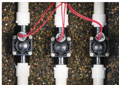
beépített PGV-100G szelep
