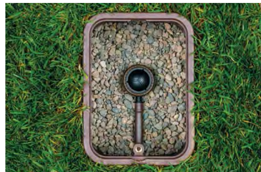
Automatikus átöblítő szelep beépítve
